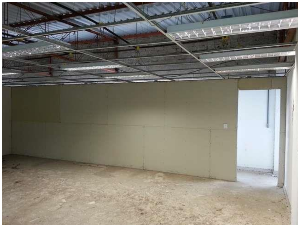
Figura 28 – Instalação das luminárias de embutir, circuitos do QDFL12.
