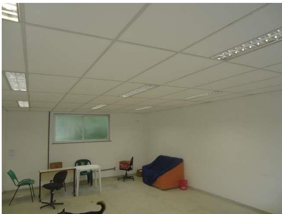
Figura 29 — Instalação das luminárias de embutir, circuitos do QDFL3.
