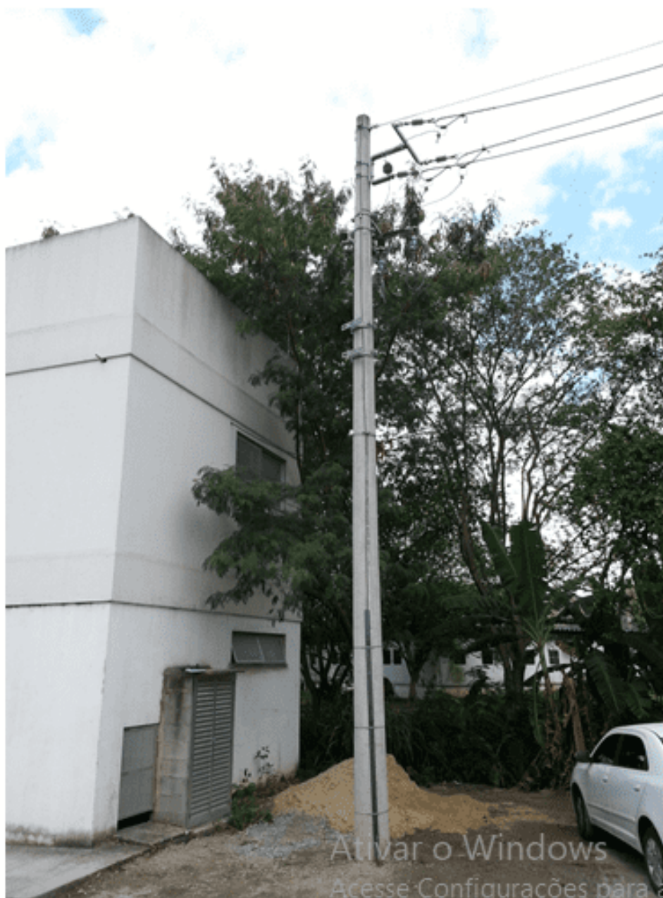
Figura 01 – Poste de Concreto Circular de 11/600 dan para Instalação do Transformador de 150KVA (SE Simplificada).
