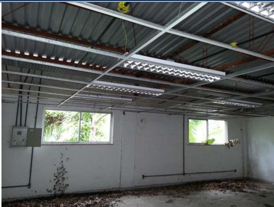
Figura 27 – – Instalação das luminárias de embutir, circuitos do QDFL14.
