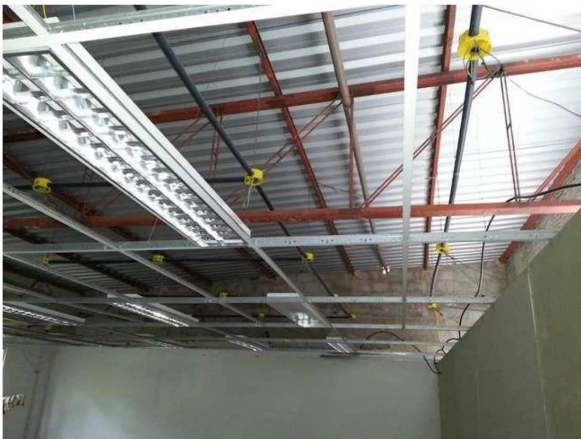
Figura 26 – Instalação das luminárias de embutir, circuitos do QDLF14.
