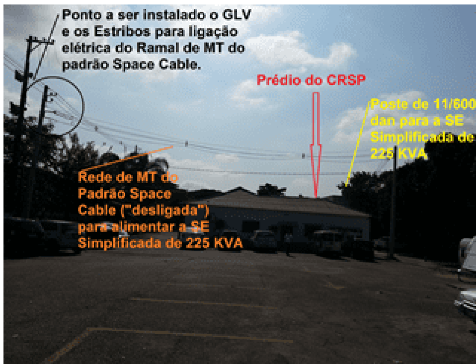
Figura 04 – Edição da imagem para melhor elucidação de conexão com GLV para a alimentação da rede de M.T
