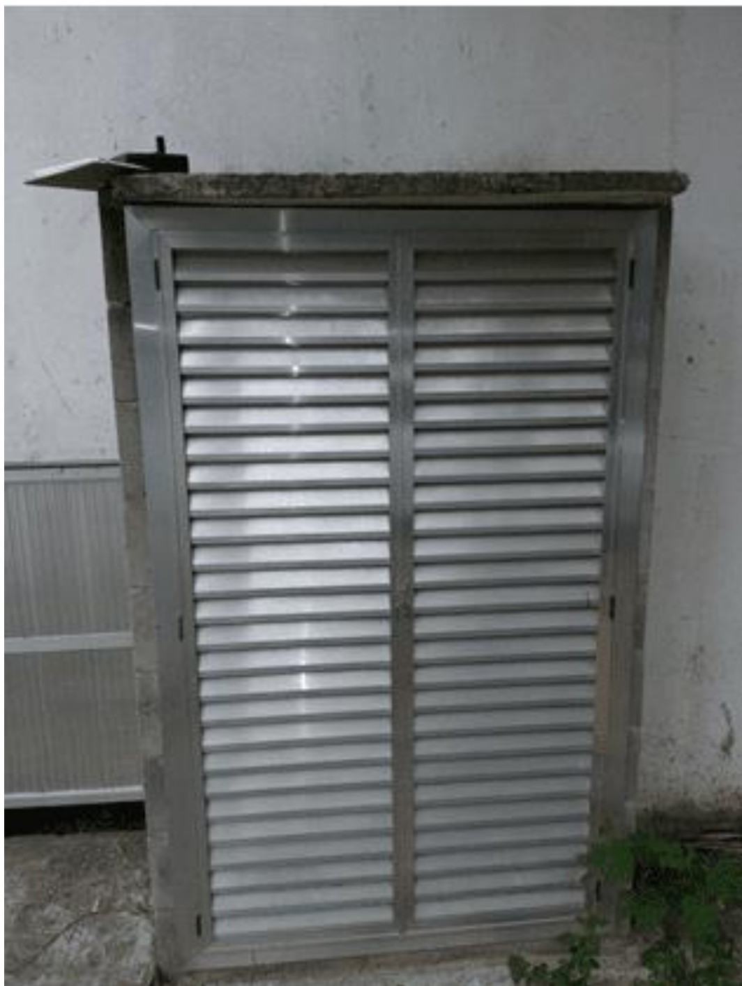
Figura 08 – Abrigo do QGBT, com lajota e portinhola em duas folhas.
