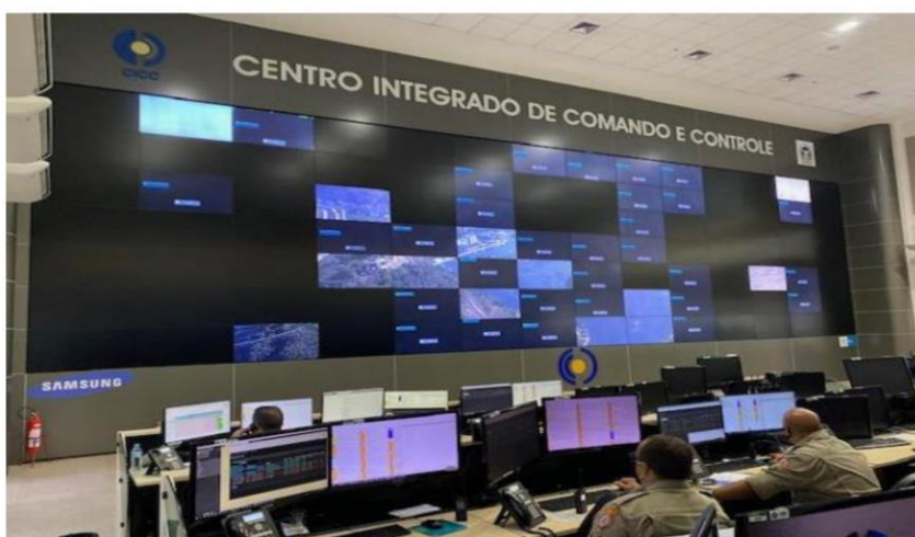
Todos os 98 monitores apresentam fadiga (linhas na tela, etc) por estarem com mais de 40 mil horas de uso.
