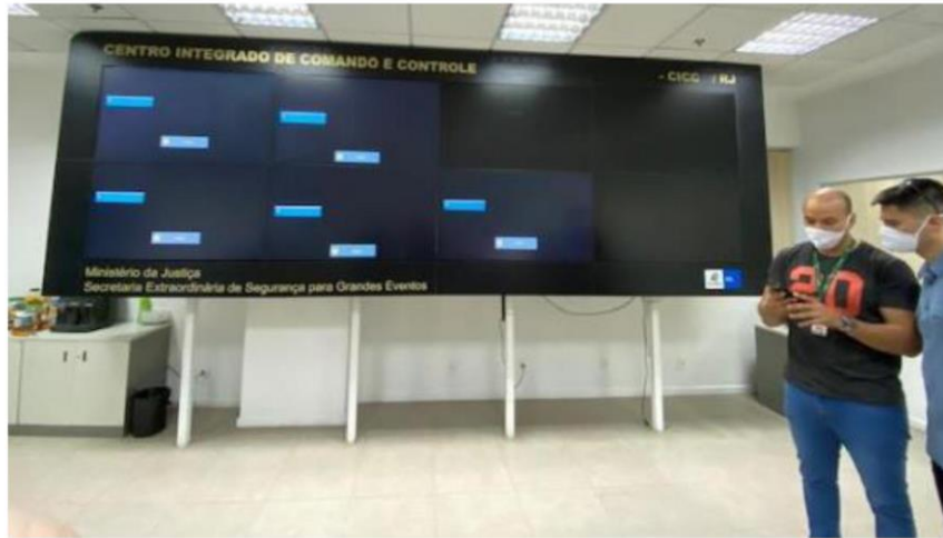
Painel composto de 8 monitores de 55 pol.
