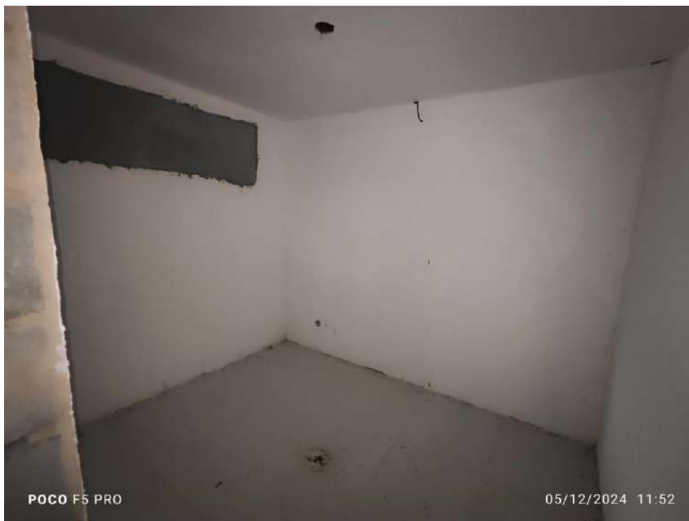
Figura 05 – Ambiente no 1º Pavimento da Edificação.
