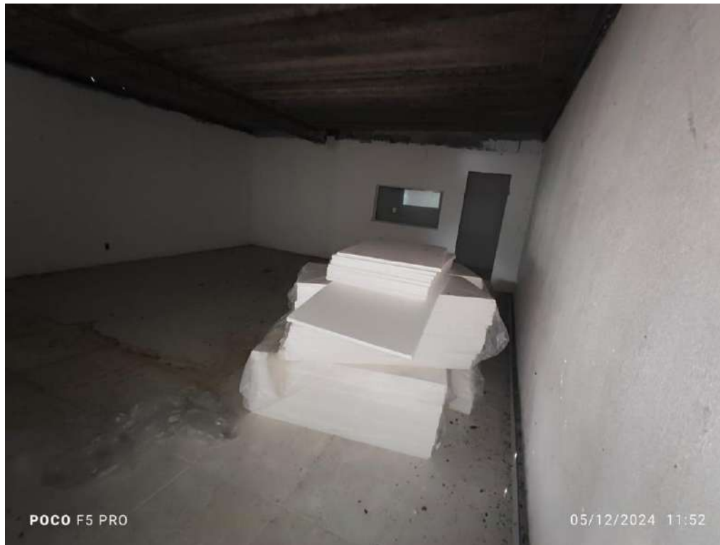
Figura 06 – Ambiente no 2º Pavimento da Edificação.
