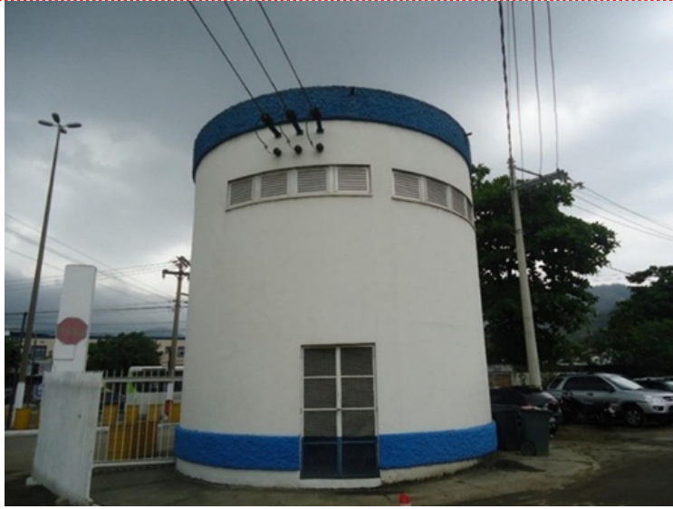
Foto 1 – Fachada do Abrigo da Subestação Blindada.
